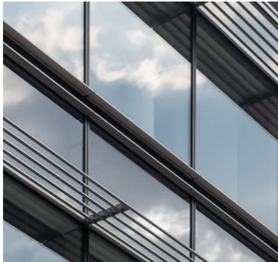
外装 自然換気口
