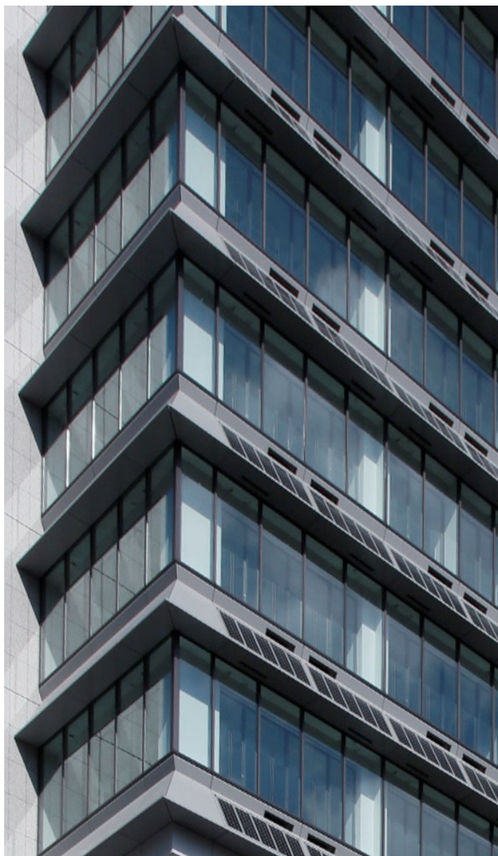
高層部南面（エコロジカルスキン）
