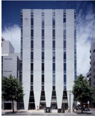
Tビル 8-9 , 2006年 送水: 日中、夜間
