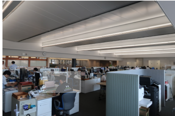
オフィスの水冷媒天井放射パネル（放射パネルは大梁フランジ下端へ設置の導光板からのリフレクターとして間接照明に活用）
